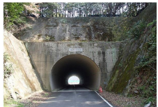
写真-2.4 筒戸トンネル
