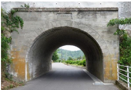
写真-2.3 箕ヶ岩トンネル
