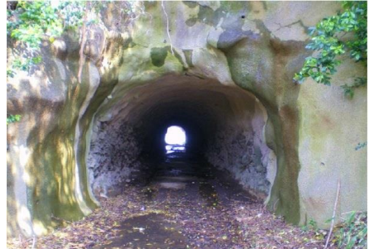
写真-2.2 唎ノ浦トンネル
