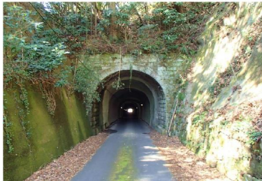
写真-2.1 朝来隧道
